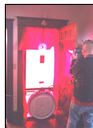
Blower Door Test
