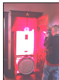
Blower Door Test
